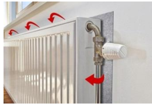
Slika 7: kroženje zraka okoli radiatorja
